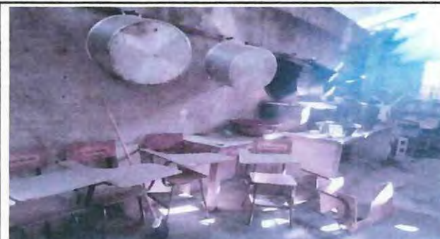
Foto 4: Modulo 1, cocina, elaboración mueble de concreto.
