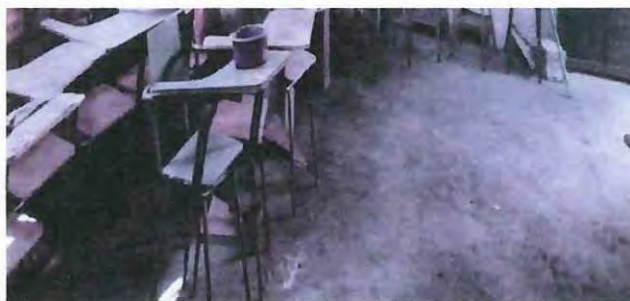
Foto 8: Módulo 1 cocina, sustitución piso alisado a piso cerámico
