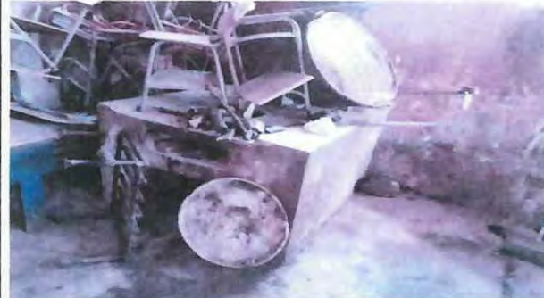
Foto 2: Módulo 1 cocina, reparacion cocina, intervencion estufa rural, demolición y elaboracion de estufa rural de menor altura.
