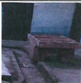
Foto 3: Módulo 1, cocina, sustitución pila de cemento 2 lavaderos aereos con almacenamiento de agua en el interior.
