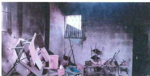
Foto 7: Módulo 1, cocina, elaboración y instalacion Ventana tipo balcón
