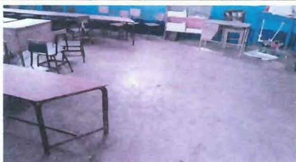
Foto 9: Módulo 2 aula 1, sustitucion piso alisado a piso cerámico
