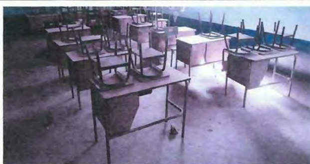
Foto 10: Módulo 2 aula 2, sustitución piso alisado a piso cerámico
